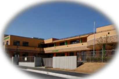
緑が丘はぐみの杜保育園 047-458-7005 (最寄駅) 八千代緑が丘 駅
